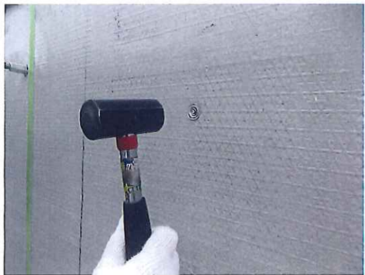
③アンカーピン打込み
