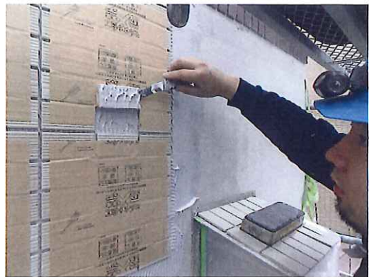
④弾性接着剤タイル張り
