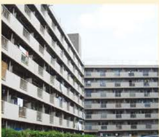
現場全景(千葉県某物件)
