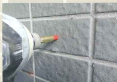
④ 座掘り作業
