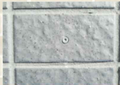
⑧ GNSアンカー打込み完了
