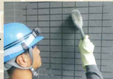
⑨ 洗浄作業
