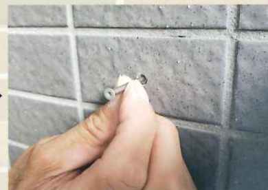
⑥ GNSアンカー挿入
