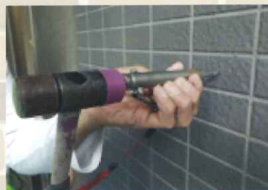
⑦ GNSアンカー打込み
