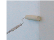
仕上げ材施工
